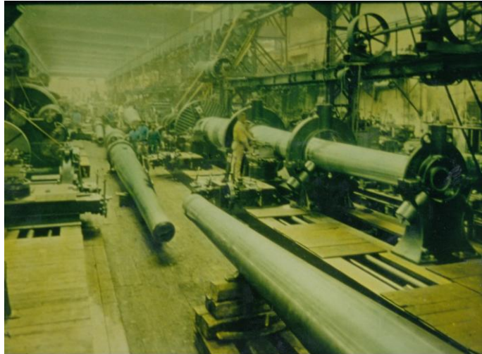
Az összerakott 305 mm-es ágyúcső az esztergapadon - Arzenál
